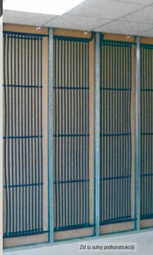
Zid/strop (u žbuci)
