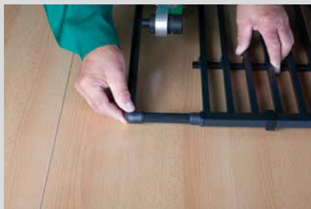
Zavarivanje komada cijevi
