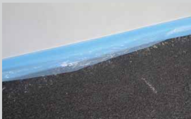
Postavljanje rubne izolacijske trake
