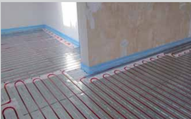
Završeni sustav grijanja TS
