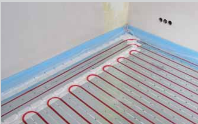
Završeni sustav grijanja TS
