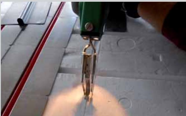
Potrebni dodatni kanali za cijevi, kao što su priključne cijevi, izrađuju se rezačem sa žarnom niti.
