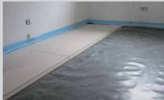
Prije instalacije suhih elemenata postavlja se PE folija.
