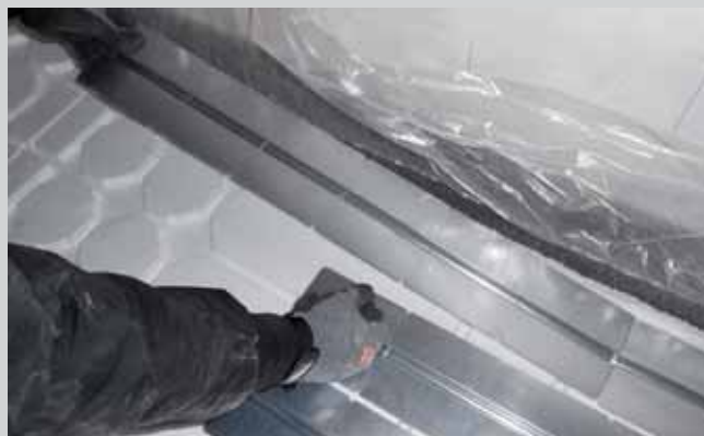
Ugradnja limova za provod topline
