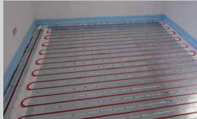
Završeni sustav grijanja TS
