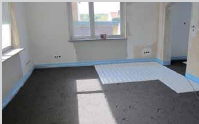
Postavljanje sistemskog elementa
