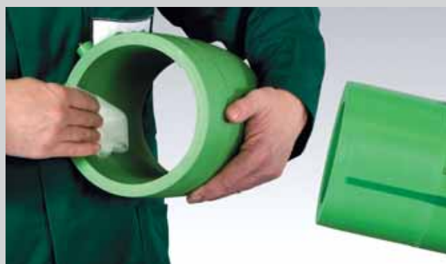
Očistiti unutarnju površinu E-spojnice
