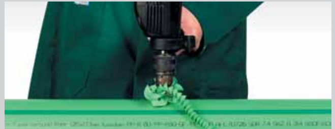
Bušenje stijenke cijevi
