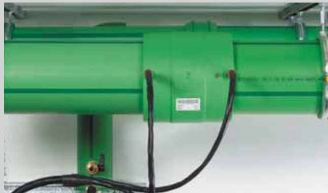
Aparat za zavarivanje podesiti na promjer spojnice. Pokrenuti postupak zavarivanja. Pridržavati se vremena hlađenja. Dovođeno!
