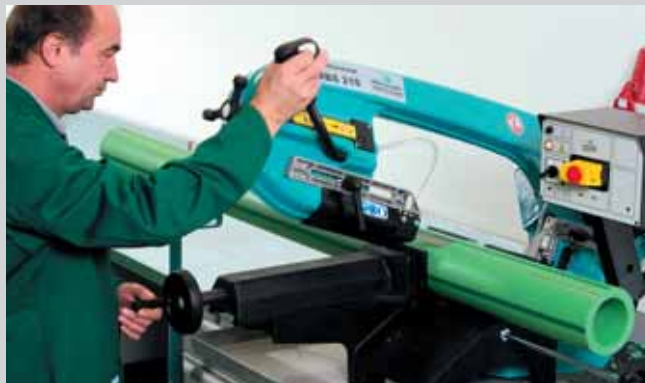
Prije zavarivanja, cijevi se režu na potrebne duljine
