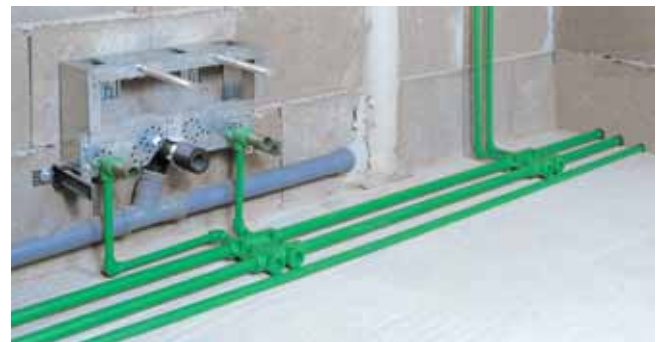
Razdioba po katovima s razdjelnim blokovima
